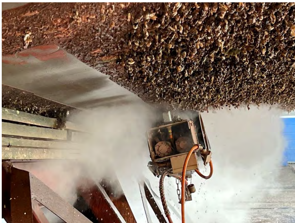
Obr. 2 Magnetický manipulátor na bázi vysokorychlostních rotačních vodních paprsků, spodní část lodního trupu s usazeninami s viditelnou oblastí (vlevo) vyčištěnou pomocí manipulátoru na bázi vysokorychlostních rotačních vodních paprsků.
